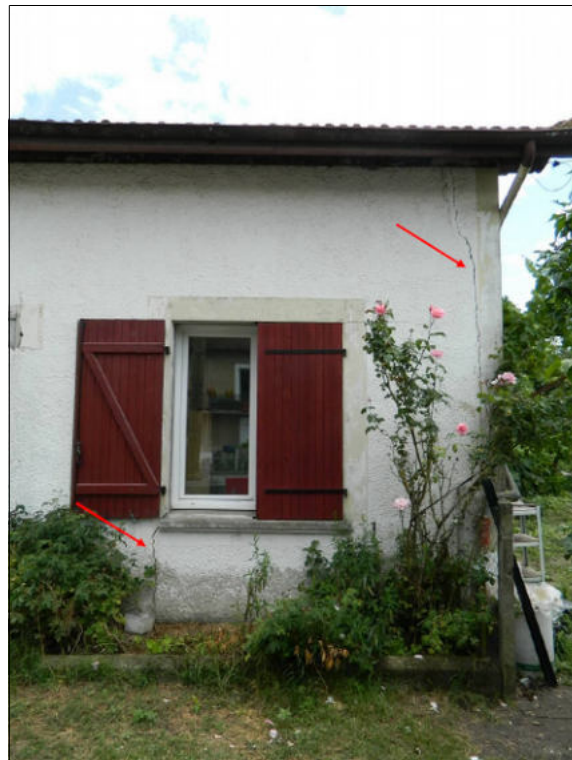
Fig. 43 : Fissuration sur un chemin (à droite) et sur le bâti (photo de gauche) en périphérie des effondrements [Source : BRGM]
