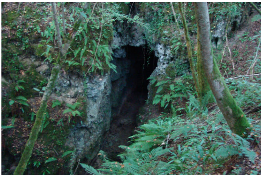
Fig. 13 : Conduit karstique (calcaires Maastrichtiens) permettant le passage du ruisseau du Cros sous la piste menant à l'ancienne carrière (piste située à droite, non visible sur la photo)
