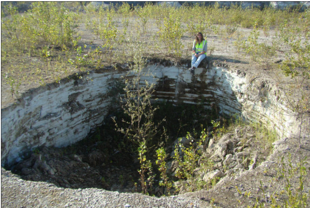
Fig. 52 : Fontis d'environ 10 m de diamètre (désordre n° 1 dans l'étude BRGM) [Source : IMS RN ]
