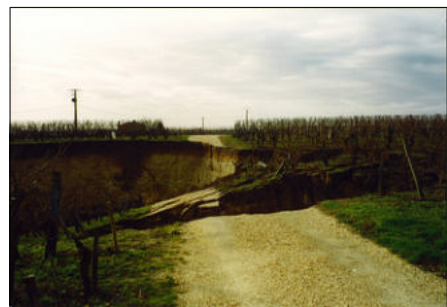
Fig. 20 : Schéma conceptuel d'un effondrement généralisé [Source : BRGM] et photographie d'un effondrement généralisé à SAINT-EMILION (Gironde) [Source : CG 33]
