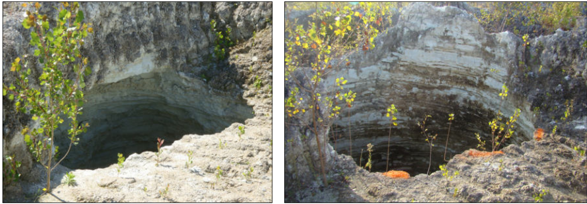
Fig. 54 : Evolution du fontis n° 6 entre le 1er juin 2012 (à gauche) et le 12 septembre 2014 (à droite) par effondrement de la couverture des déchets de papeterie [Source : BRGM / IMS RN ]
