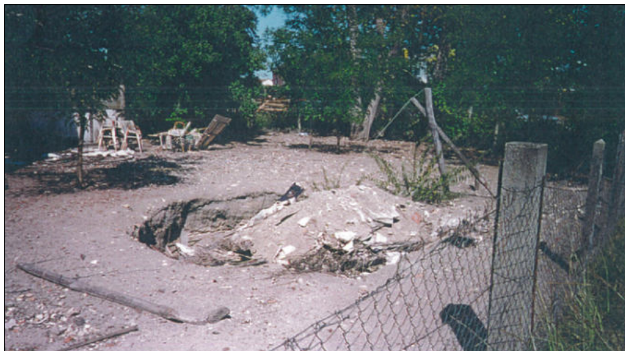
Fig. 29 : Fontis en partie remblayé à l'angle du chemin de Cousseillat et de la RD 932 [Source : ANTEA]
