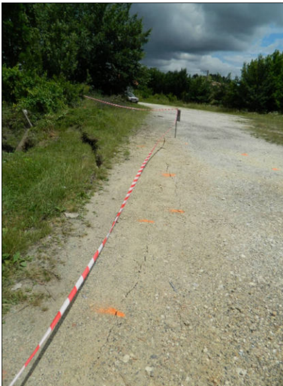
Fig. 43 : Fissuration sur un chemin (à droite) et sur le bâti (photo de gauche) en périphérie des effondrements [Source : BRGM]
